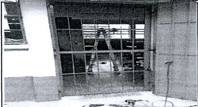
Foto 2: instalacion de la puerta
