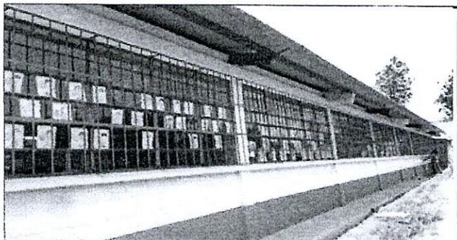
Foto 6: colocacion de los balcones
